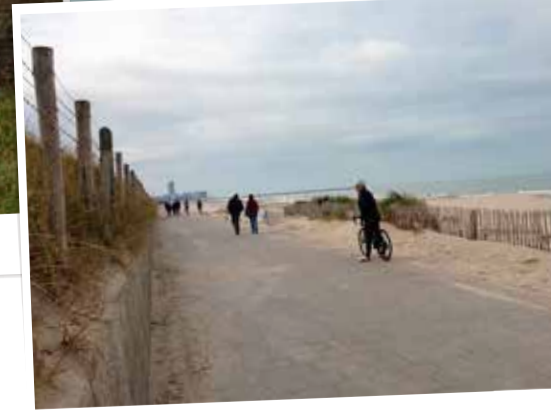
Spinoladijk. Oostende in de verte.
